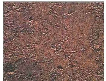
État D Sablé à Sa 1
